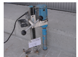
②コンクリートコア削孔工 (≒φ52×床版)
