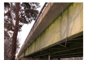
⑥完成 (パイプ下部にはフレキシ ブルチューブで流末接続)
