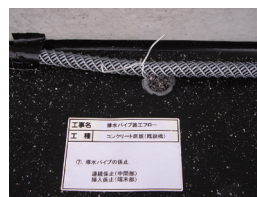
⑤導水パイプの係止 (中間部の連続係止および 端末部の挿入係止)
