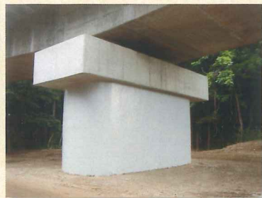
炭素繊維シート補強後
