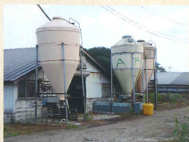
ガイナ施工(飼料タンク)
